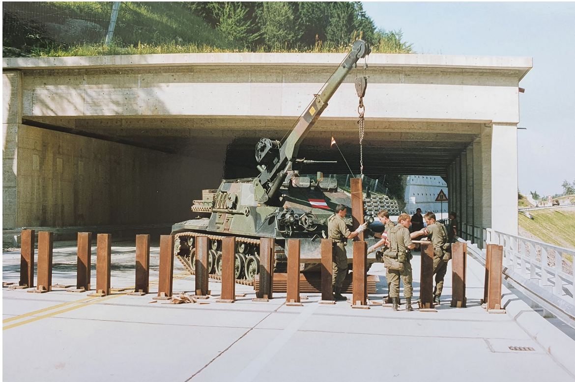
► Fährliche aktivieren die Stecksperrre beim Nordportal des Karawankentunnels
