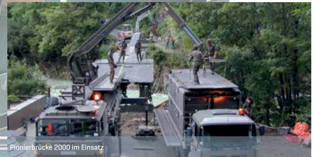
Sicherstellung der eigenen Beweglichkeit durch Brückenbau.
