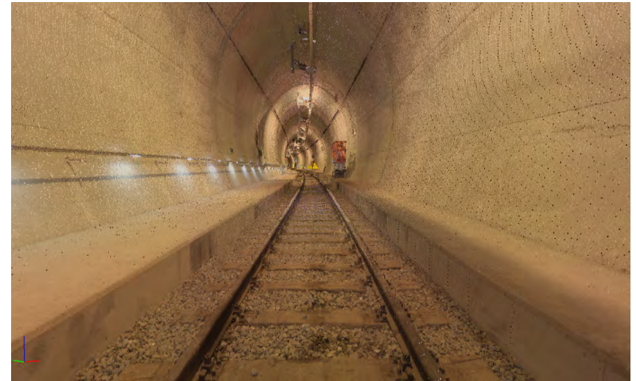
Abbildung 7: Der Laser-Scan kann ein sehr realistisches Planungsumfeld in der Virtual Reality schaffen (Forschungsgruppe NIKE).
